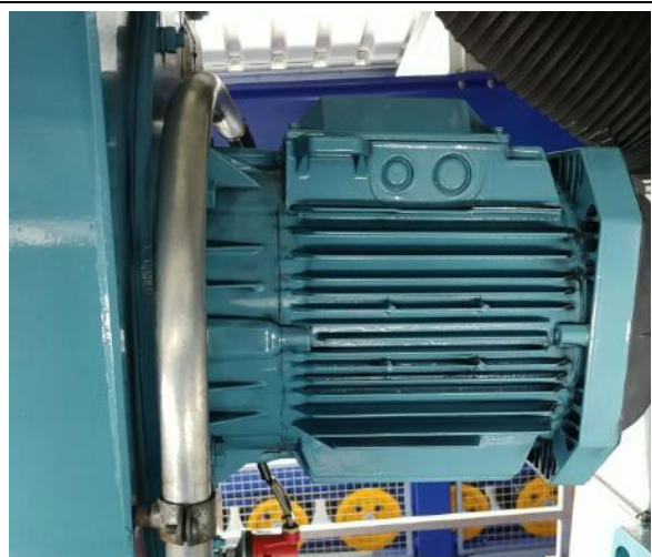
Antrieb für Lüfter
